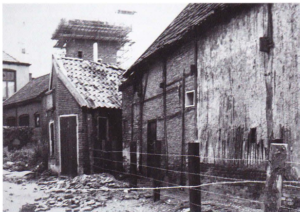
Zijwand vóór de restauratie
