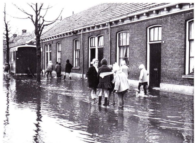
De Polswoningen aan de Oldenzaalsestraat onder water. Deze woningen werden onbewoonbaar verklaard en in de jaren '60 gesloopt
