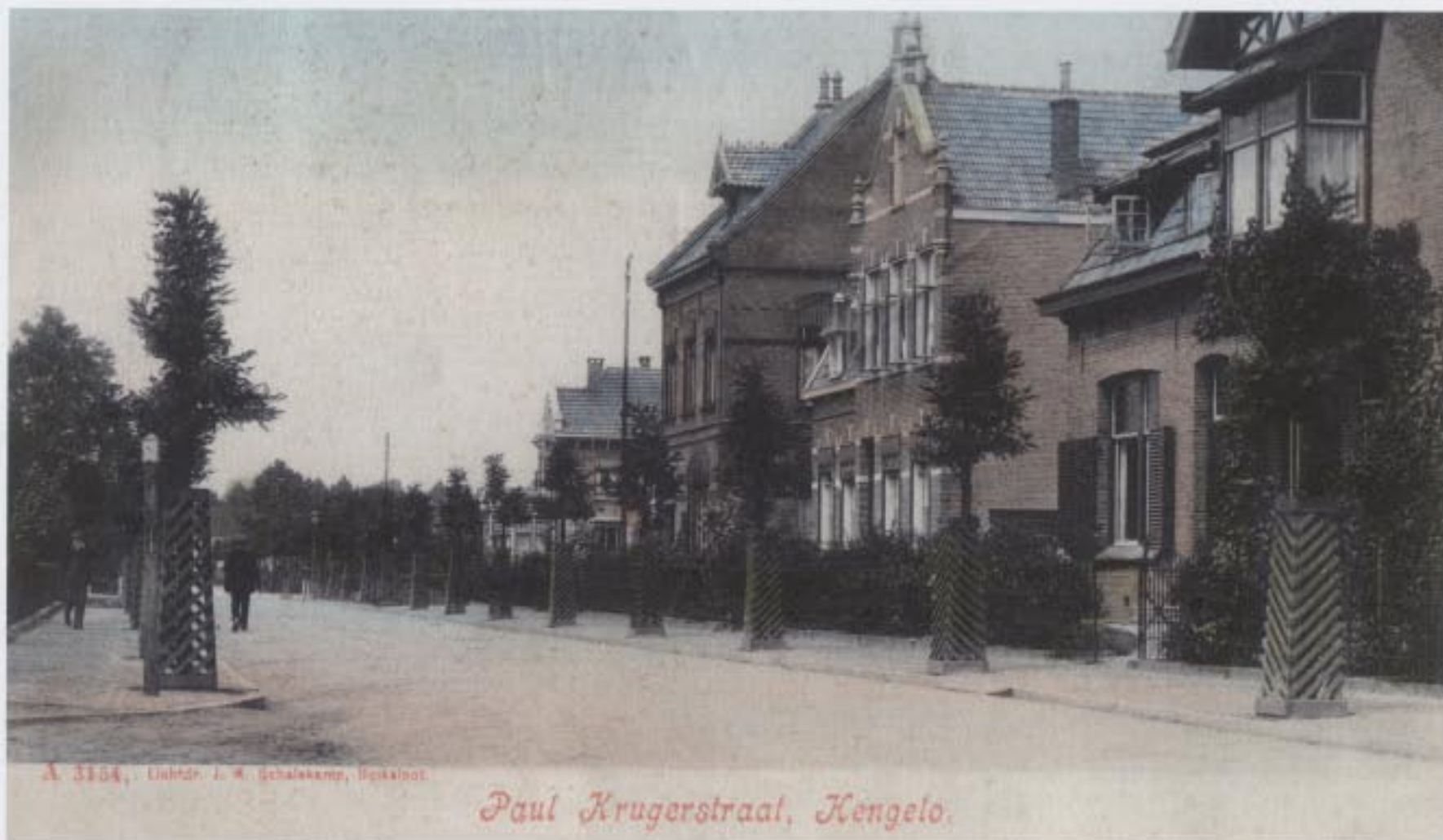
De drie herenhuizen die werden afgebroken voor wat nu het kantoor van Welbions is.
