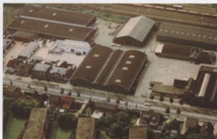
De DOH in de jaren tachtig, nadat de 'waterkolken' op het terrein zijn gedicht met het puin van de schoorsteen.
