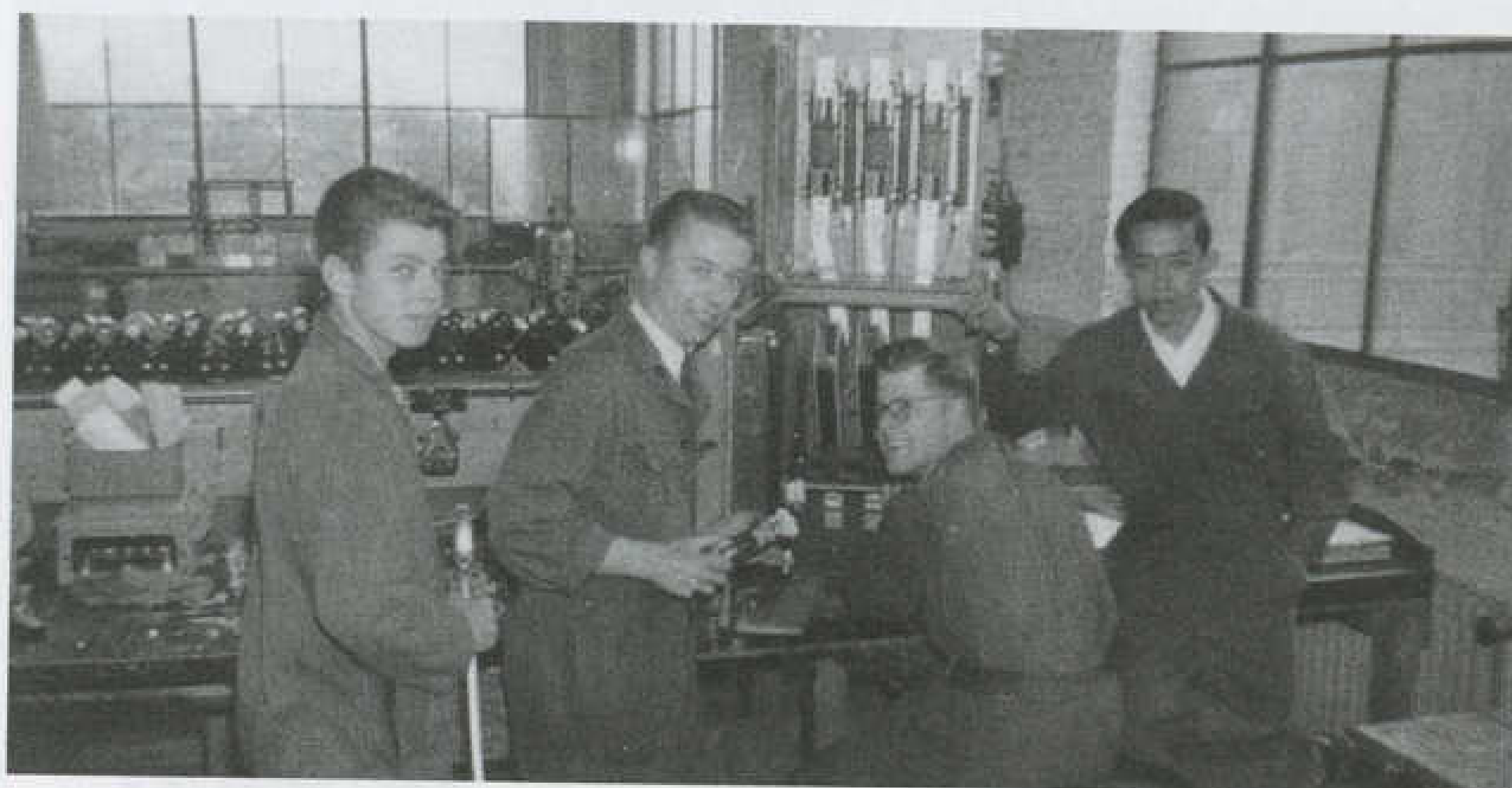
1958-1959 Hazemeijer, bankwerkers afdeling Laagspanning, boven de grote Reyrolle-hal (1922). Van links naar rechts: ?, Andries Arendsen, Sjaak Geerdink en John Overklift.
