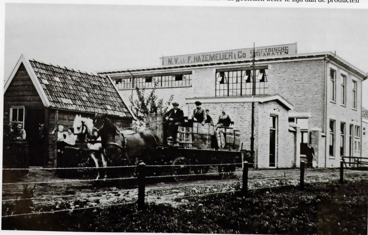
Figuur 1. Vestiging Tuindorpstraat
