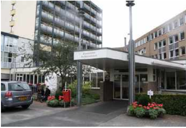
Het verzorgingstehuis van Humanitas aan de Hennepstraat
