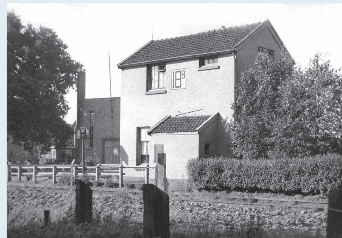
De overweg in de Twekkelerweg met het seinhuis van de GOLS-spoorweg. Op de achtergrond het pand van drukkerij Insulinde.
