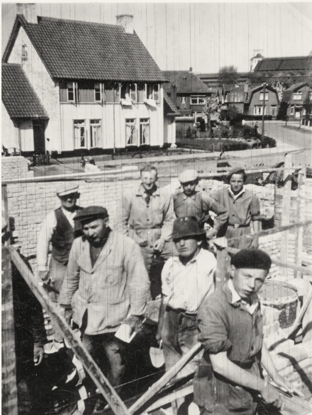
1945 - 1946, de bouw van noodschool 't Kotte. Wie zijn deze vakmannen, metselaars?
