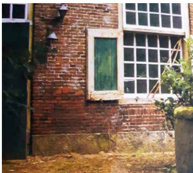
Het grondhout vervangen door Bentheimer zandsteen
