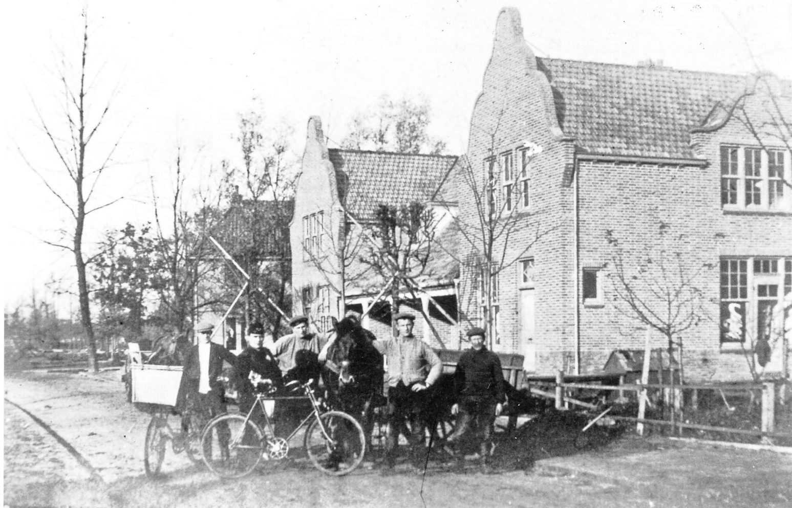
Van Markenstraat in aanbouw.
